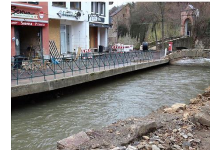
Das alte Geländer wird verschwinden, das neue bietet mit Stahlplatten im unteren Bereich Hochwasserschutz.
