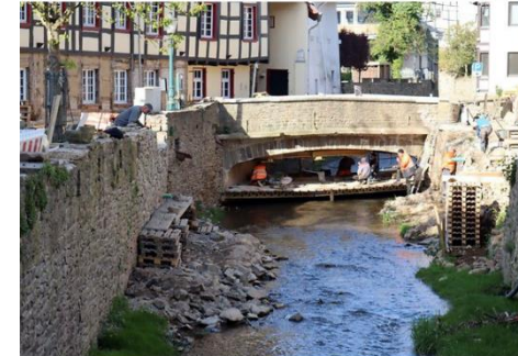
Die Ertfbrücke an der Fibergasse wird saniert.
